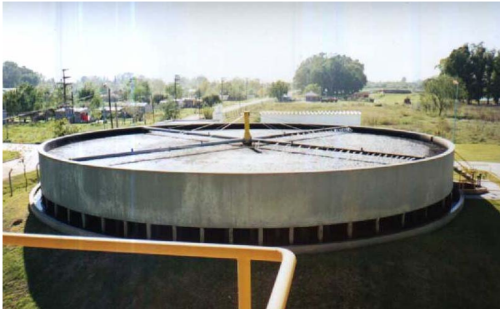
Vista completa de un lecho percolador. Obsérvese el brazo distribuidor hidráulico y las ventanas en el inferior del equipo que permiten la ventilación del lecho.
