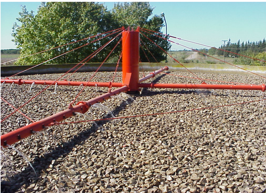
Foto de la superficie de un lecho percolador de piedra como material fijo y distribuidor hidráulico
